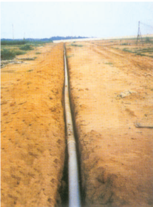
连云港化工园区污水处理厂
